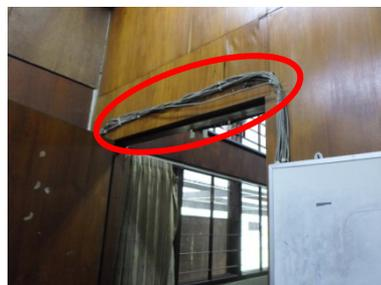
Foto 18. Foto Instalasi kabel tanpa penutup
