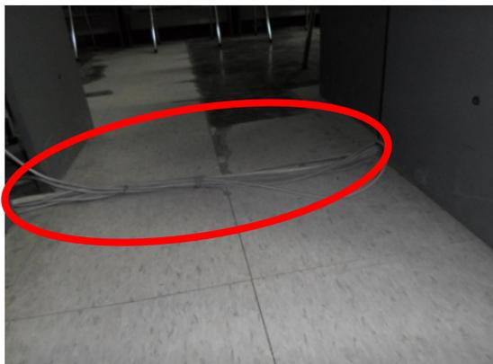
Foto 14. Foto Sambungan kabel tanpa pelindung di Ruang laboratorium komputer dasar
